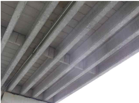
거더 및 바닥판하면 전경
